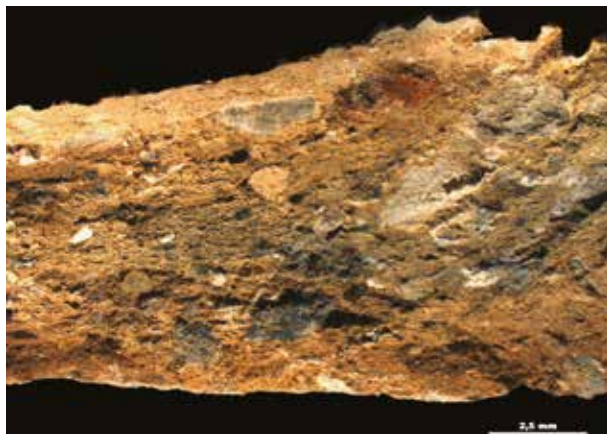
Figura 88 – Paredes poco comprimidas, que conservan la mesoestructura de los rollos, con pocas fisuras subparalelas
