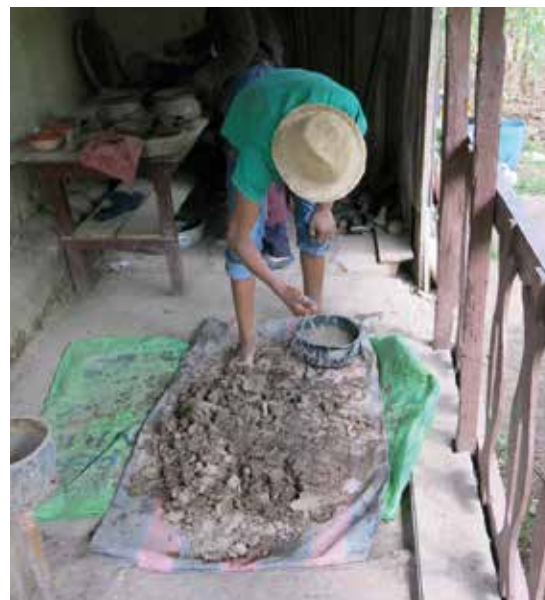
Figura 132 – Hidratación por humectación (Sígig, Ecuador)
